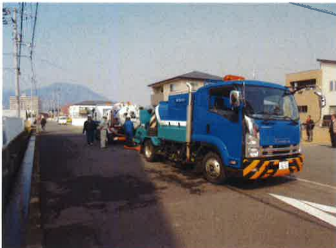
洗浄車・吸引車設置状況
